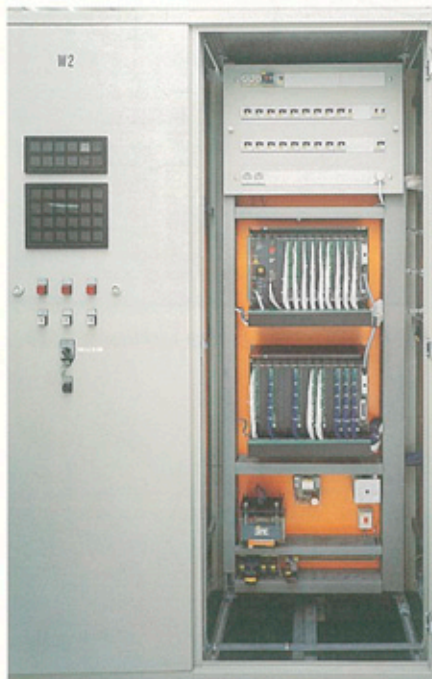
▲ Niederspannungs-Verteilung mit Stromschienenabgang nach unten ▲ Störmelde-Überwachungsschrank mit Verteiler für die Zentrale Leittechnik und SPS
